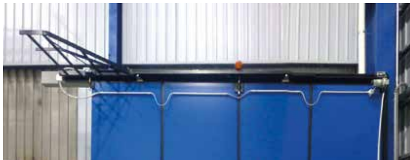
Vista interna portone a libro Anteo con motorizzazione meccanica a cremagliera completa di motore 24 V, installato su anta.
