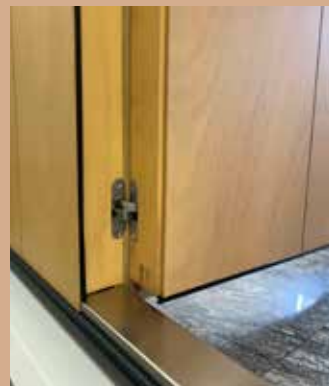
6. La soglia inferiore della porta pedonale è rivestita con un profilo in acciaio inox.
