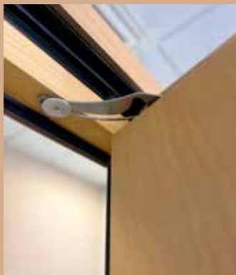
5. La porta pedonale è dotata di compasso d'apertura (apertura massima 90°).
