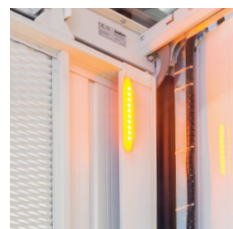
Lampeggiante a led interno, montato e precablatato.
