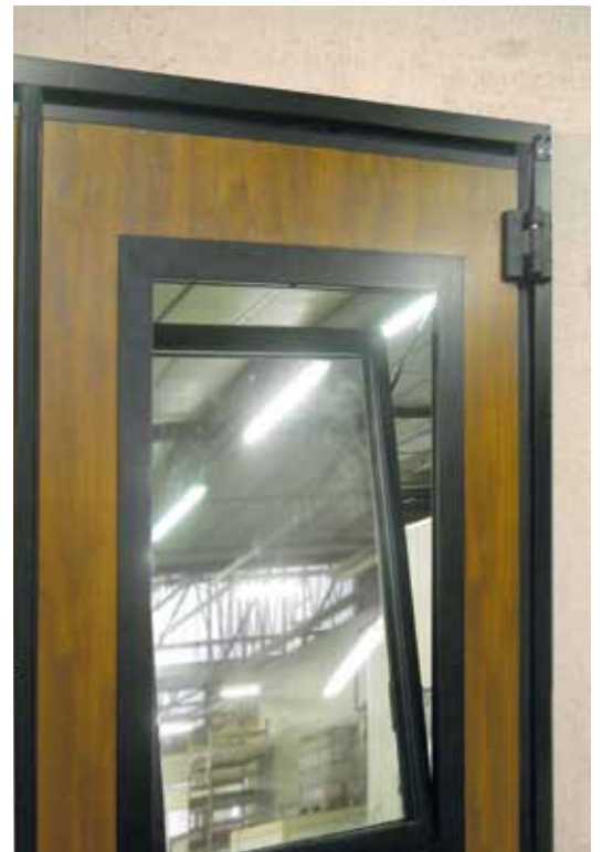
Oblò con apertura a vasistas, con profili in alluminio.
