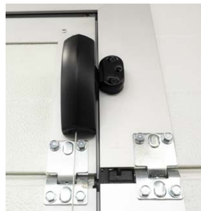
Rostro di chiusura gestito dal maniglione antipanico
