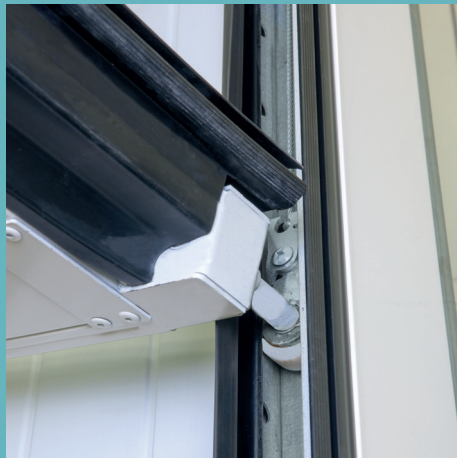
Dispositif pare-chute inséré dans les rails. Il intervient en cas de rupture des câbles en bloquant la chute du tablier.
