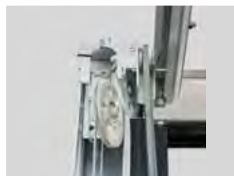
La dimensione delle carrucole di rinvio garantisce lunga durata alla fune in acciaio e un corretto posizionamento del contrappeso.
