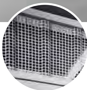
Particolare del sopraluce oltre l'anta mobile in lamiera fori quadri 8x8 mm.
